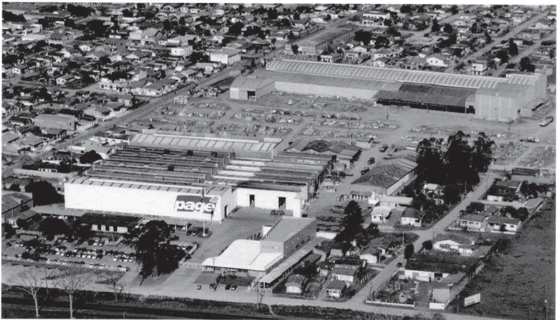
Vista área do Parque Industrial da Pagé
