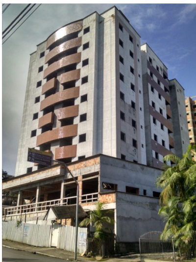
Fachada Principal ângulo nordeste
