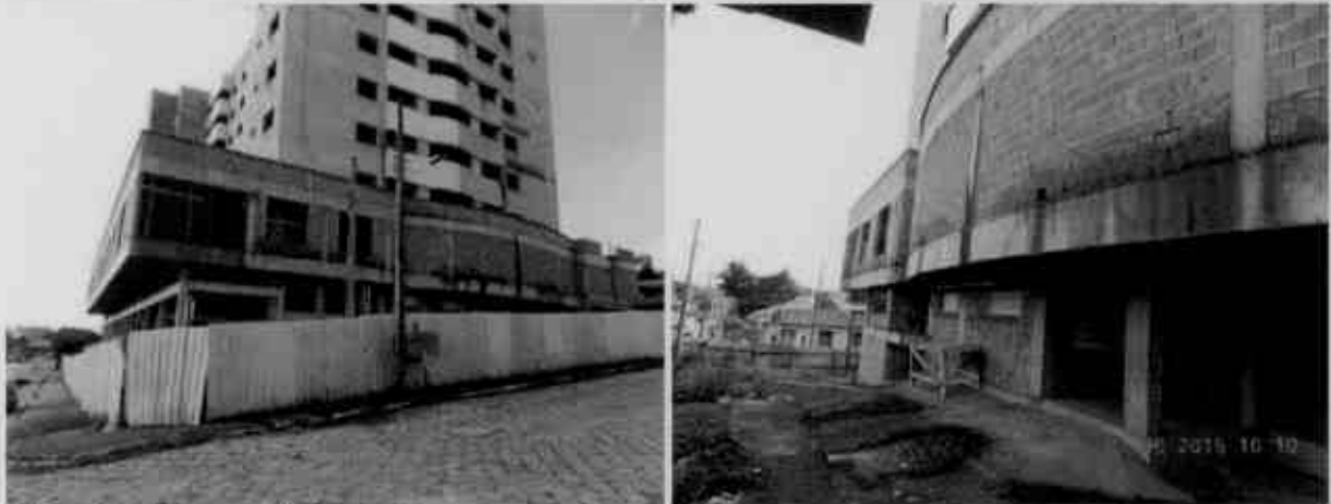
Figura 3 – Vista parcial do imóvel.
