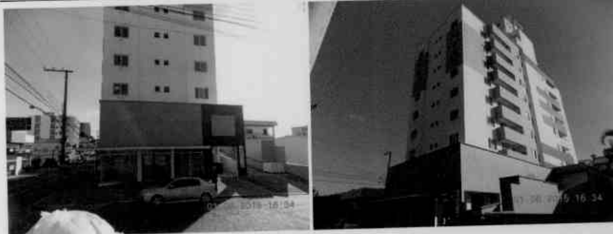
Figura 3 – Vista parcial do imóvel.
