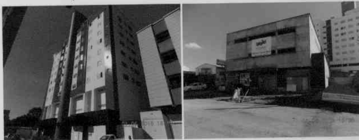
Figura 5 – Parte residencial concluída. Parte comercial em fase de acabamentos.
