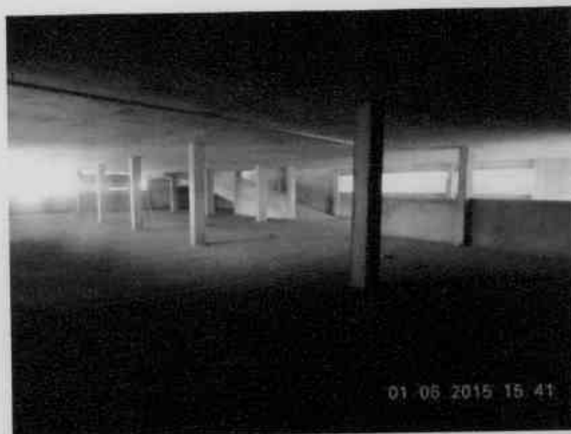
Figura 21 – Obras em andamento.
