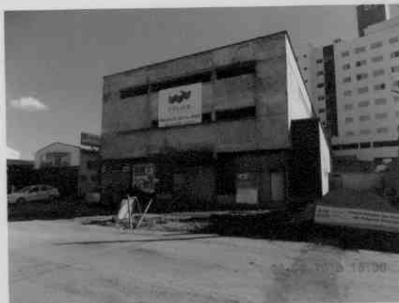
Figura 19 – Parte comercial inacabada.
