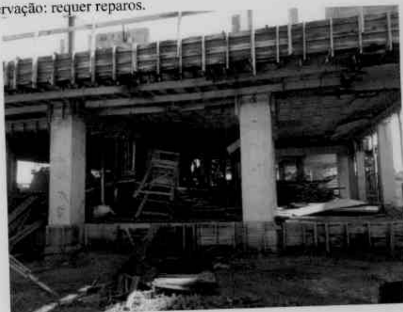
Edifício Moradas do Atlântico.
