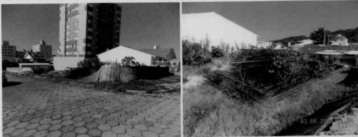
Figura 3 – Vista parcial do imóvel.
