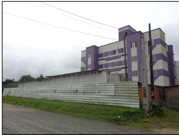
Imagem 01 – Vista frontal do imóvel.
