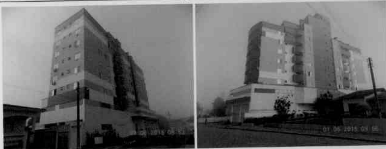
Figura 3 – Vista parcial do imóvel.
