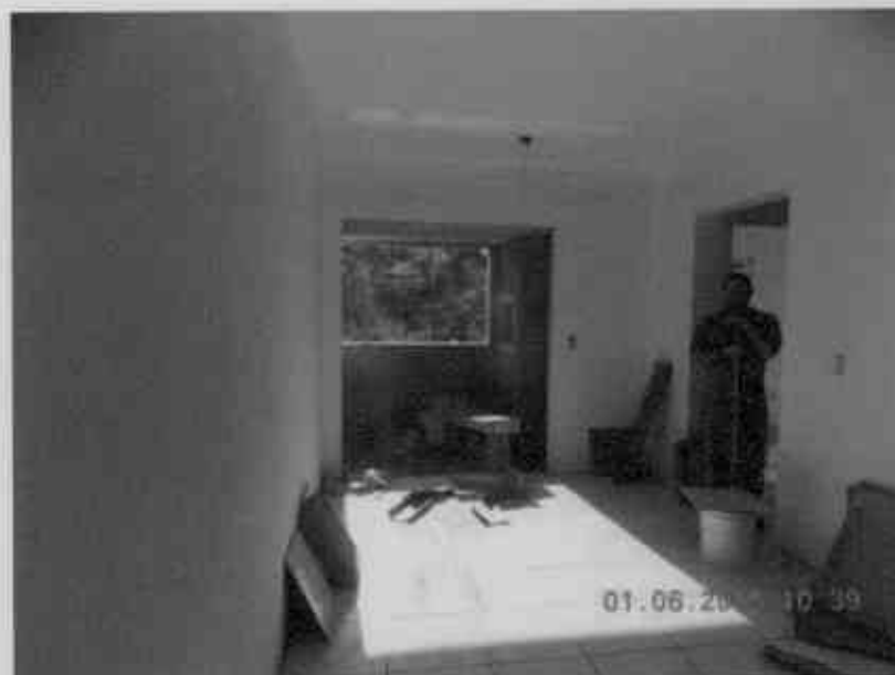
Figura 7 – Obras em andamento.
