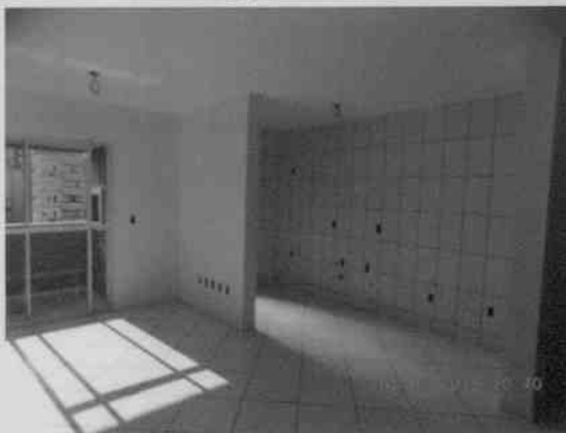
Figura 6 – Interior dos apartamentos.
