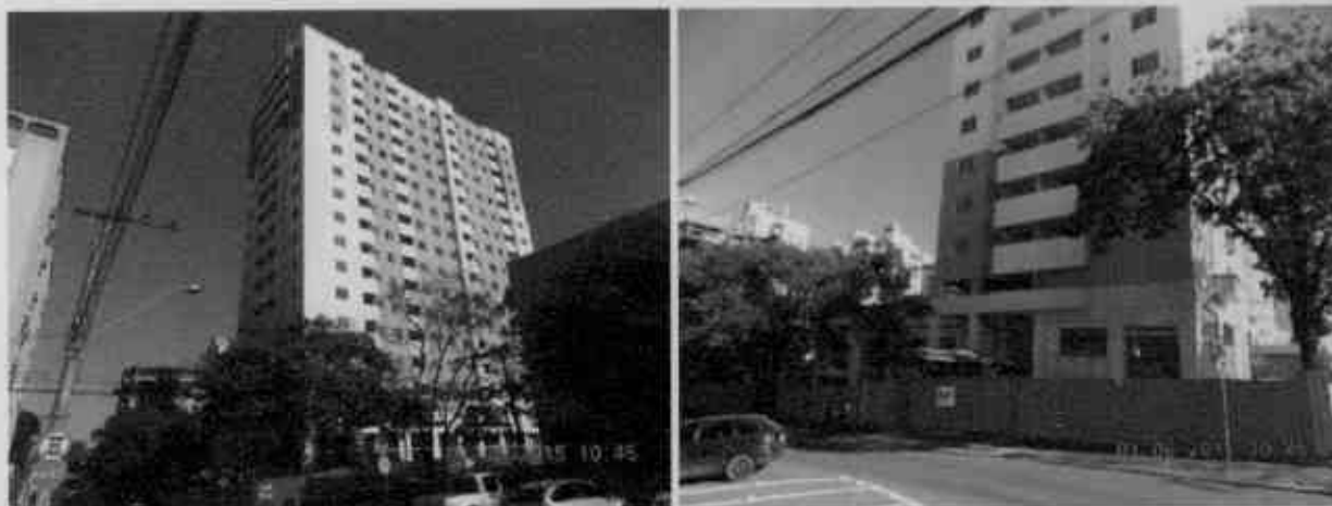
Figura 5 – Vista parcial do imóvel.
