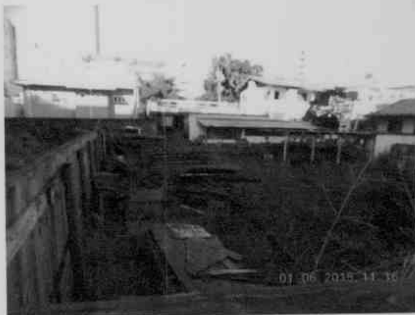
Figura 6 – Edificação uso residencial, material para a fundação.
