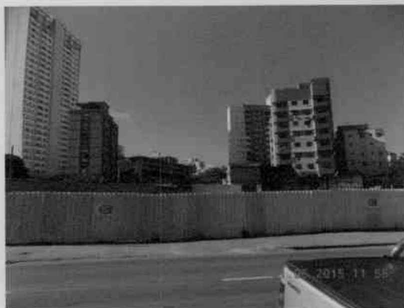
Figura 7 – Terreno cercado e limpo. Obra não iniciada.
