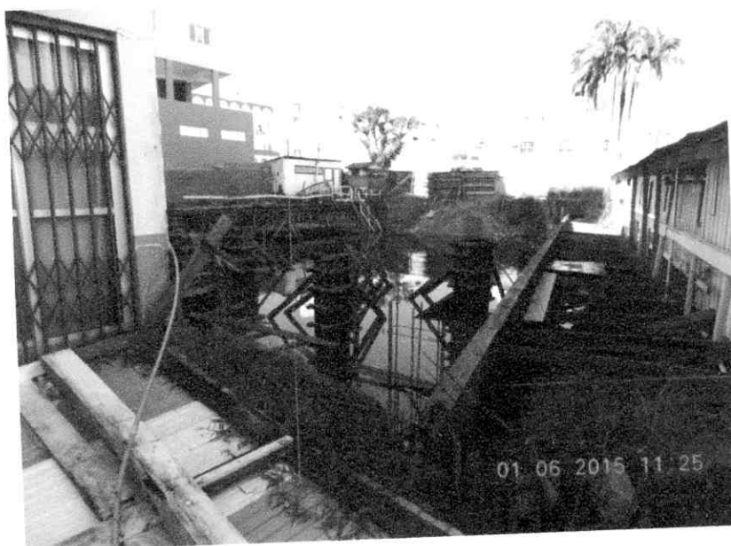
Figura 6 – Edificação uso misto comercial e residencial. Fundação inacabada.
