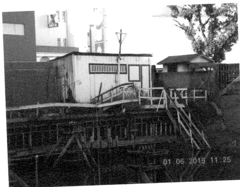
Figura 7 – Edificação uso misto comercial e residencial. Fundação inacabada.
