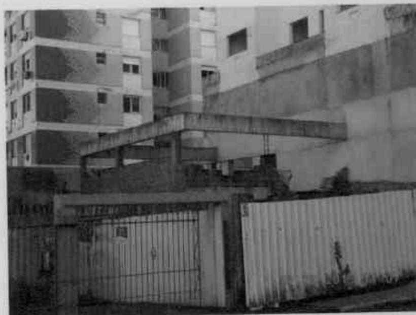
Figura 7 – Edificação uso residencial, inacabada.
