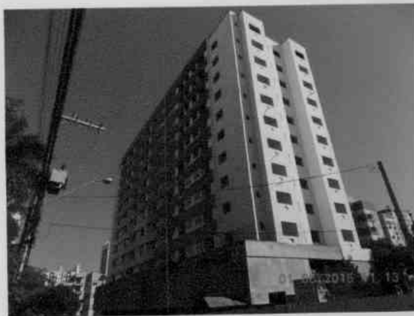
Figura 6 – Edificação uso residencial, inacabada.
