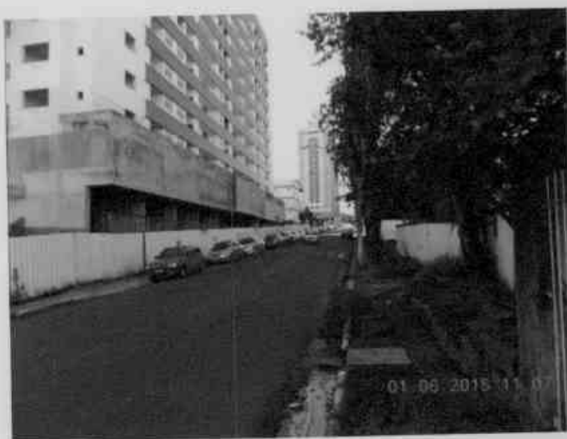
Figura 5 – Vista parcial do imóvel, revestimentos em andamento.
