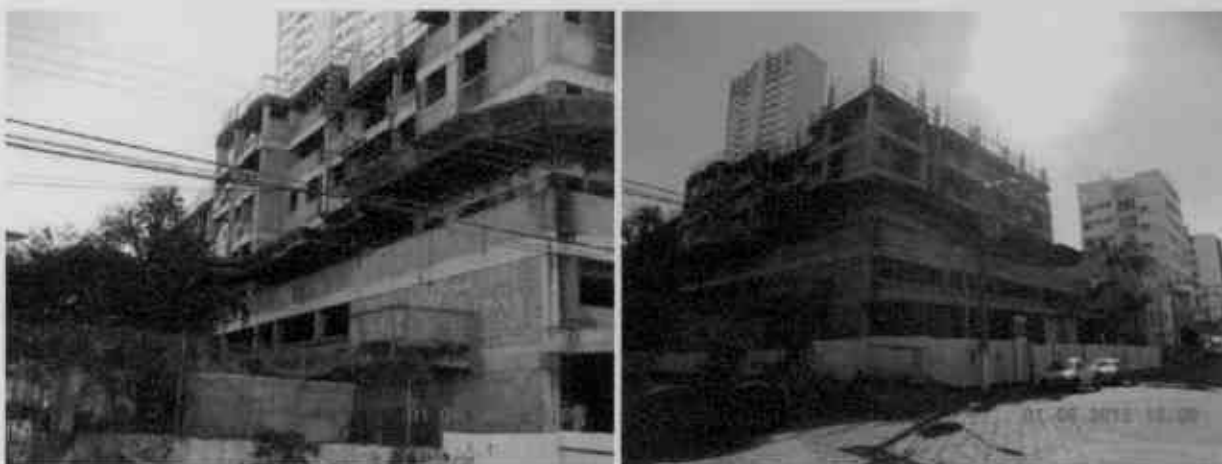
Figura 5 – Vista parcial do imóvel, estrutura e alvenaria em andamento.
