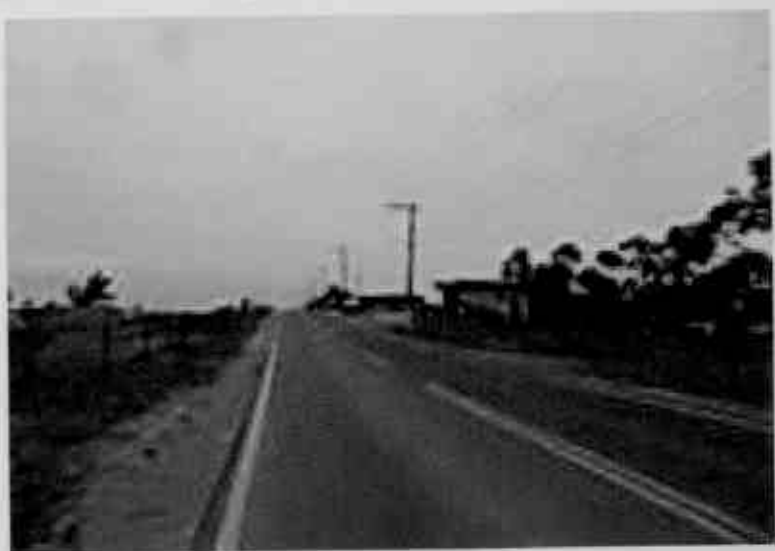
Figura 5 – Acesso ao imóvel em estudo.
