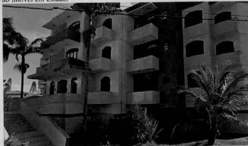
Figura 4 – Vista Parcial da Edificação.
