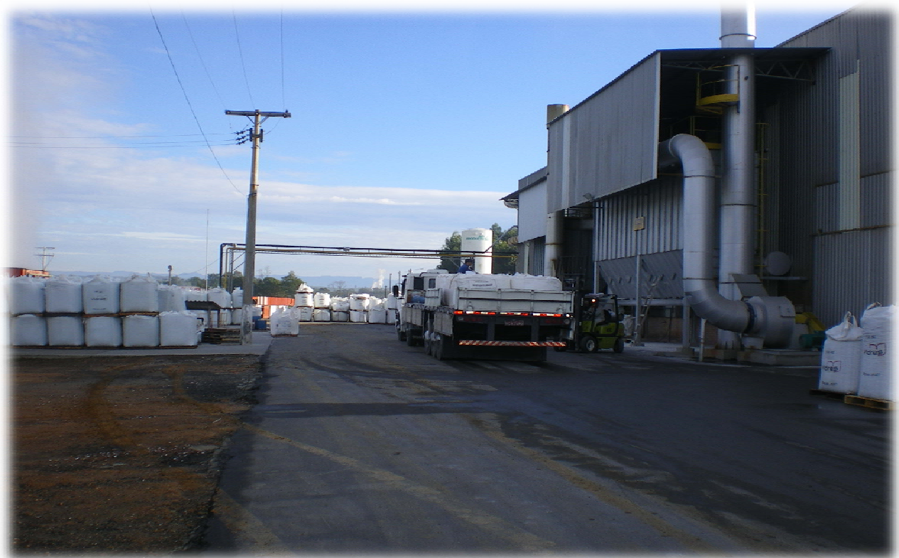
Área de depósito da planta de Criciúma/SC
