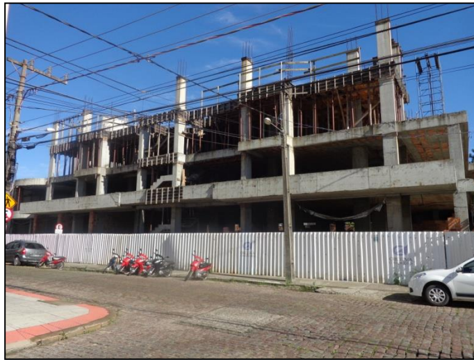
Imagem 01 – Vista frontal do imóvel.
