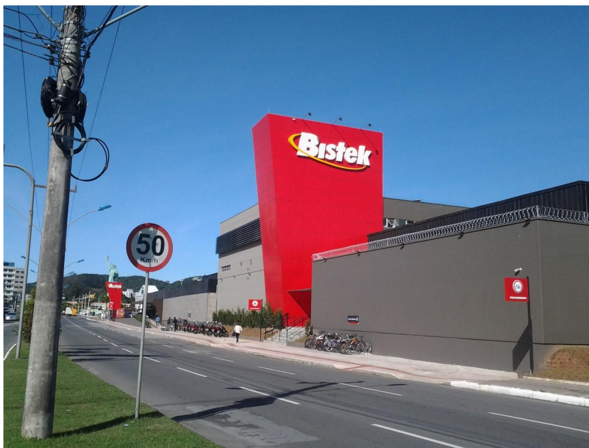
Figura 13 - Frente do imóvel
